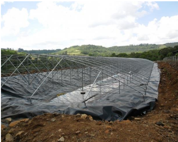
Figura 2. Fundação de uma cisterna em zona rural.
